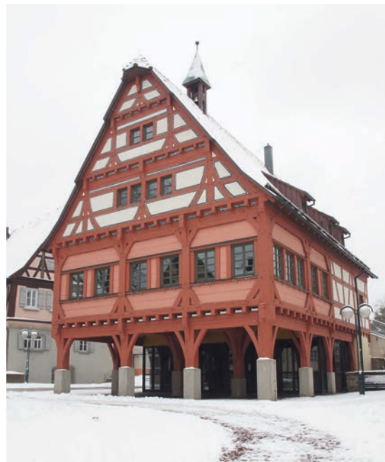
Abbildung 1: Plochingen, Rathaus aus der Zeit um 1520. Unten »alemannisch« oben »fränkisch«? Hier helfen auch die besten Betonfundamente unter den Freistützen nichts: die Begrifflichkeiten stehen auf tönernen Füßen (Foto: T. Marstaller, 2013).
