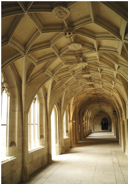
Abbildung 4: Kloster Bebenhausen, Blick nach Osten in den um/kurz nach 1496 i fertiggestellten Südflügel des Kreuzgangs (Foto: T. Marstaller, 2010).
