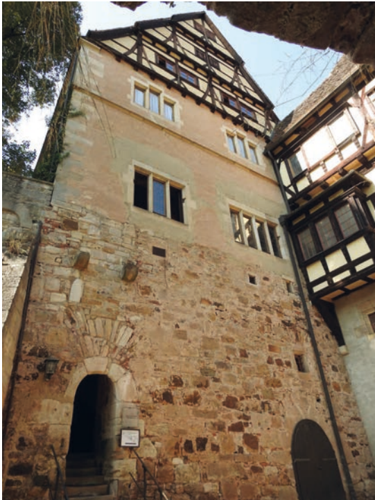
Abbildung 5: Kloster Bebenhausen. Ostseite der 1507 i erbauten, um 1885 aufgestockten Abtsküche, auch »Dachsbau« genannt (Foto: T. Marstaller, 2020).
