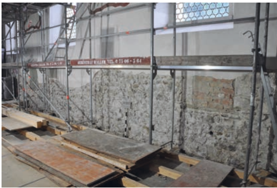
Abbildung 10: Ravensburg-Eschach, SS Maria und Nikolaus: Südwand mit zugemauerter Öffnung und opus spicatum (LAD Tübingen, Foto: E. Rümmele, 2017).
