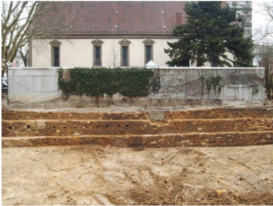
Abbildung 11: Göppingen, Roth-Carrée. Fundamentierung der Contrescarpe vor dem westlichen Stadtgraben (Foto: Kreisarchäologie Göppingen).
