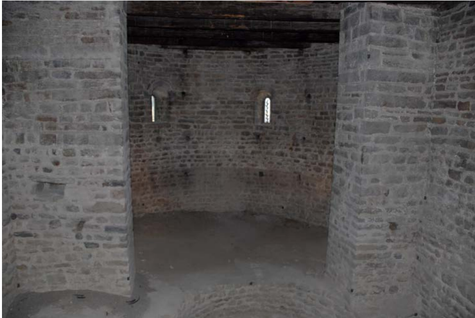
Abbildung 7: Krypta von Schloss Tirol. Die B-Gerüstlöcher sind an der deutlich erkennbaren Grenze zwischen hellerem und dunklerem Putz, B 4 ist das untere Gerüstloch unter dem rechten Fenster, der Fundort B 3 liegt rechts daneben (Foto: M. Mersiowsky)
