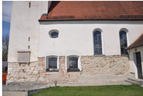
Abbildung 4: Öllingen, Ulrichskirche: unterschiedliches Sockelmauerwerk von Turm und Südwand, barocke Umbauten (Foto: LAD Tübingen, 2012).
