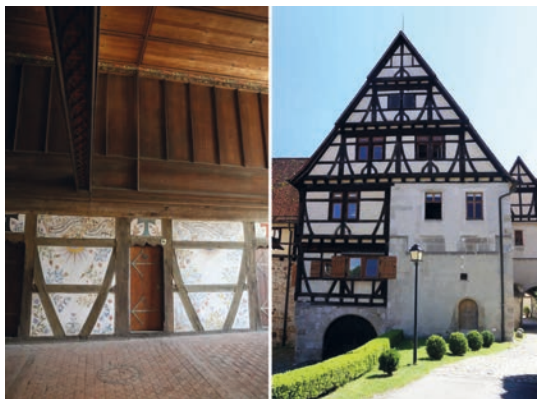
Abbildung 8: Kloster Bebenhausen. Frühneuzeitliches Fachwerk im Dormitorium des Klausurostflügels von 1513-16 i sowie am Novizenbau von 1517/18 d (Fotos: T. Marstaller, 2020).
