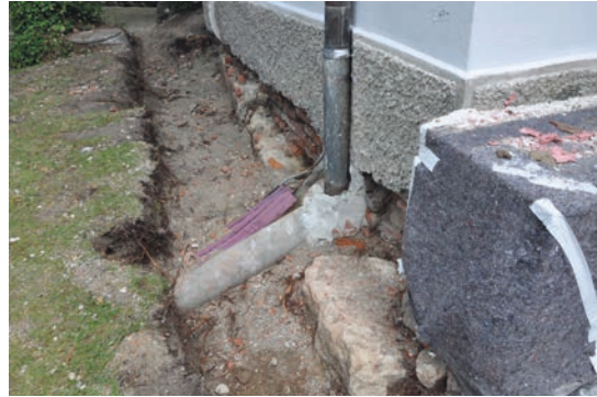
Abbildung 6: Laupheim, SS Peter und Paul: Fundamente in abweichender Flucht unter dem Oratorium (Foto: LAD Tübingen, 2012).
