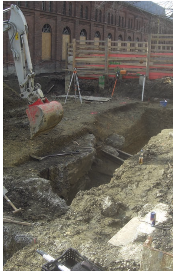
Abbildung 2: Der Splitterschutzgraben bei der Freilegung mit der Kanonenbohrwerkstätte im Hintergrund (Stadtarchiv Ingolstadt).
