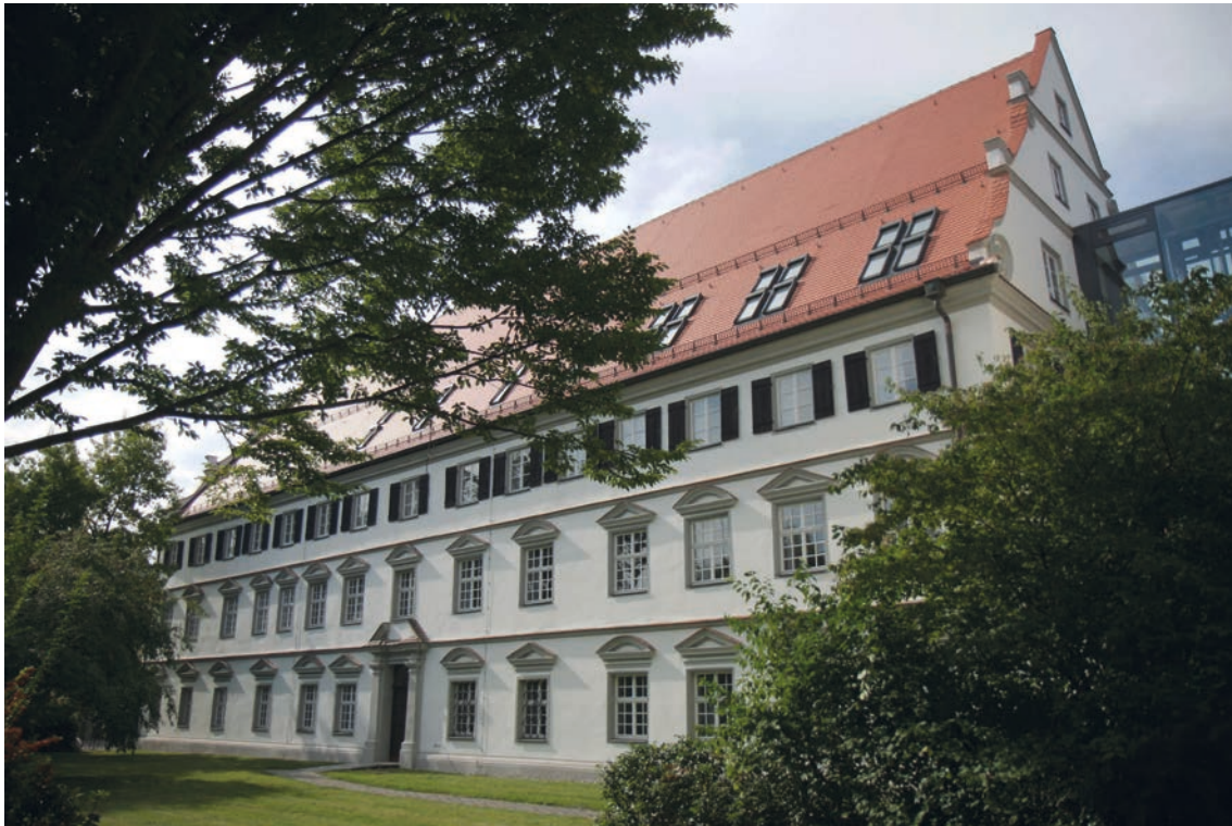
Abbildung 2: Biberach, Konventgebäude des ehemaligen Franziskanerinnenklosters von Südosten (Foto: www.commons.wikimedia.org ).
