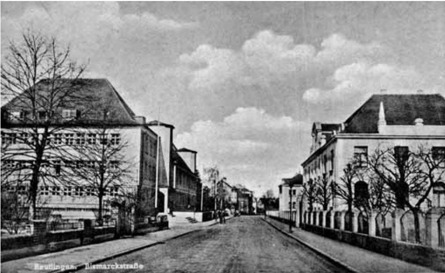
Unter Adolf Kommerell erbaut und noch heute Sitz von Ämtern des Landkreises: Gebäudekomplex Bismarckstraße 14–16 (links), hier eine Postkartenansicht der 1930er Jahre.
