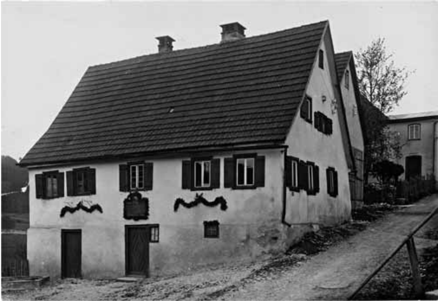
Das Geburtshaus Matthias Erzbergers in der Buttenhausener Mühlsteige. Im Hintergrund die 1938 zerstörte Synagoge.
