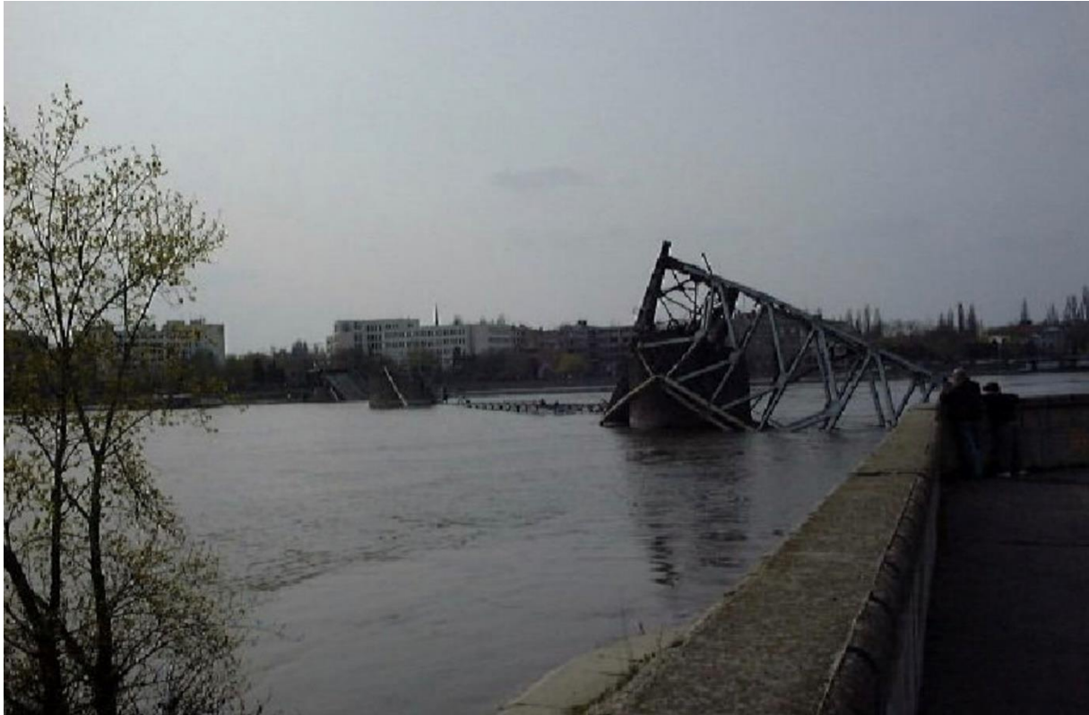
Andrej Ivanji: Zerstörte Brücke in Novi Sad, Mai 1999
