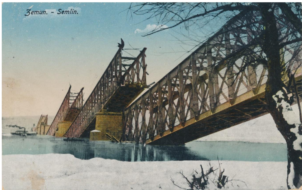
Zerstörte Brücke bei Zemun, um 1916/17, ungelaufen, kolorierter Lichtdruck, Verlag St. Sasson, Zemun
