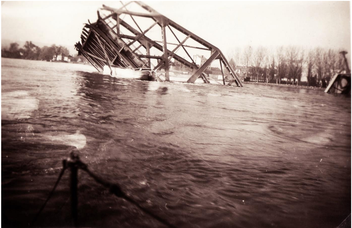
Anonym: Die Reste der am 10. April 1941 gesprengten Prinz-Tomislav-Brücke, kurz nach der Sprengung aufgenommen, Fortepan, ID 116730, Wikimedia Commons
