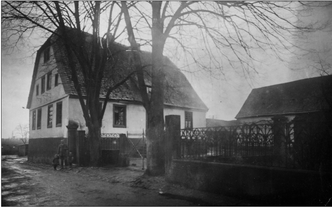
Abb. 2 Wohnhaus auf dem heutigen Grundstück Mühlgasse 7 11 (Flurstück 53 in der Mühlgasse, Hausnummer 22) in Rohrbach, im Winter 1927 (zu dieser Zeit im Besitz von Jakob Hoffmann IV.). Rechts neben dem Haus ist die ehemalige Werkstatt zu sehen (Gemeindearchiv Rohrbach 12 ).
