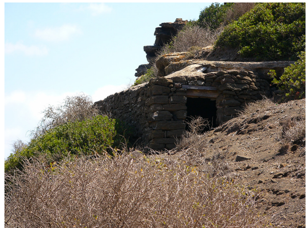
Abb. 71. Monte Calcarella, Höhlen und Anbauten aus Trockenmauerwerk im Nord-Hang.
