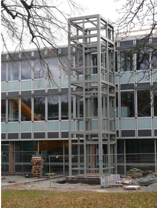
Im März sind die Fundamentarbeiten soweit gediehen, dass der Aufzugsturm gestellt werden kann und mit der Verschalung begonnen wird.
