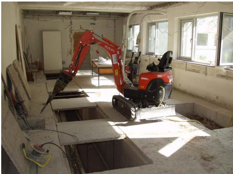
Die Entkernungsarbeiten im Foyer begannen im Dezember 2010. Hier wird seitdem mit schwerem Gerät gearbeitet, was für Lärm und Erschütterungen bis ins 2. OG sorgt. Auch hier werden während des Abbruchs Schadstoffe frei gesetzt, deshalb ist ein Entsorgungsunternehmen mit der fachgerechten Entsorgung und Abreinigung beauftragt.
