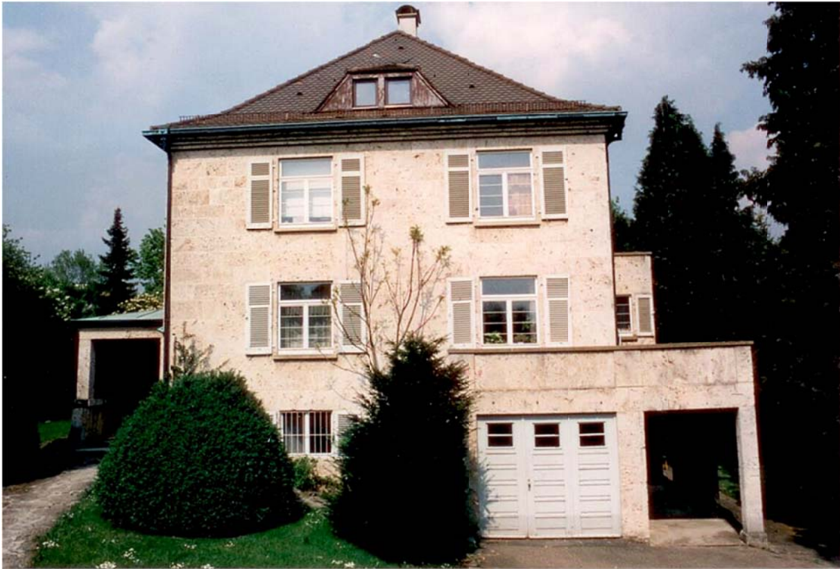
Altes Institut an der Corrensstraße
