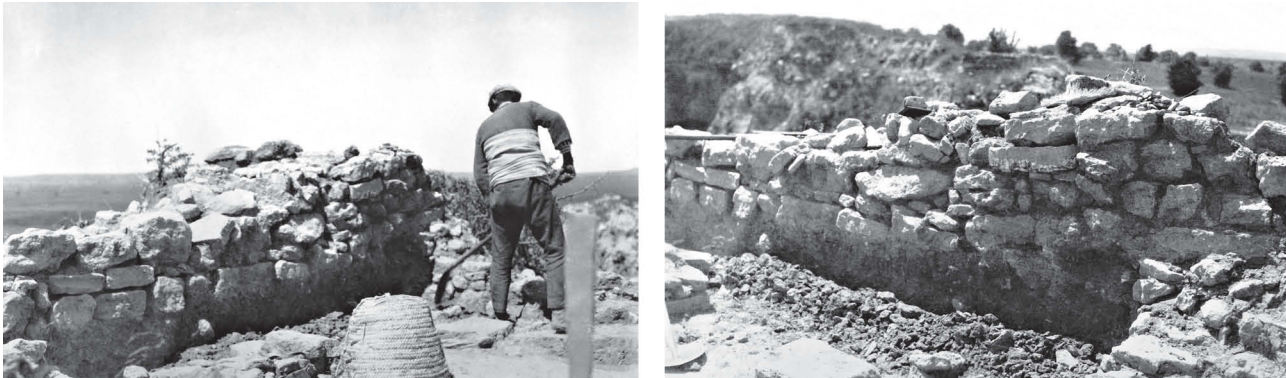
Abb. 49: Areal E6, die NW-SO orientierte Troia VI-Mauer. Blicke von NW und von O (nach Blegen-Archiv 32–14 und 32–15, Album B, 67 – zugleich Blegen et al. 1953, Abb. 2522553).
