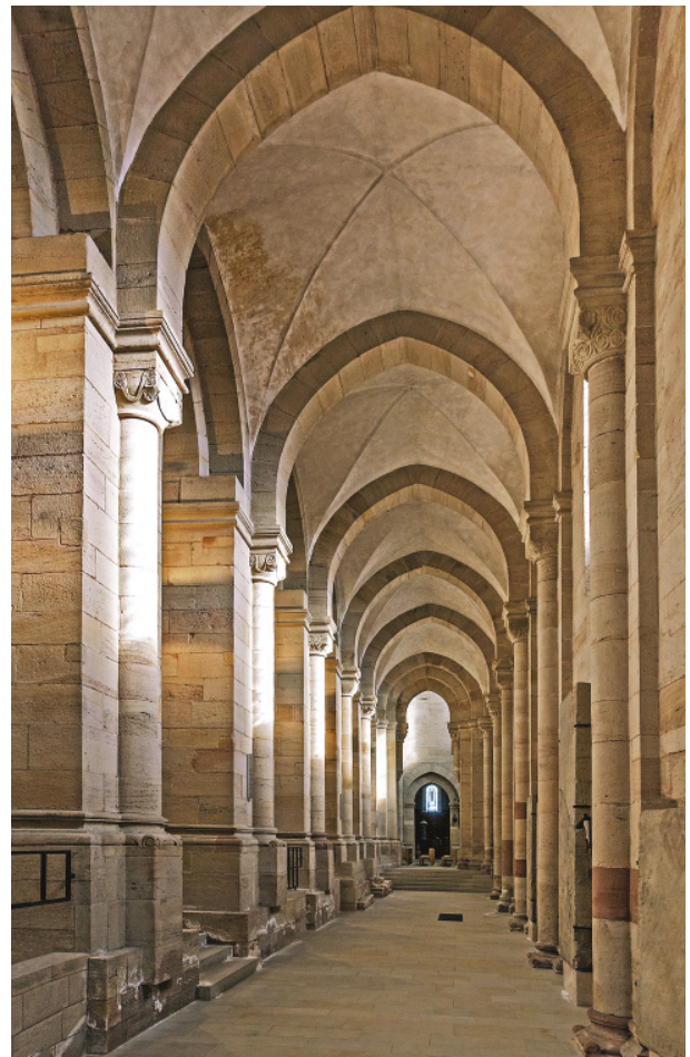
Abb. 6. Otterberg, Zisterzienserkirche, Südseiten-schiff; rechts die tief ansetzende, früh aufgegebene Wandgliederung der Außenwand, links die Mittelschiffpfeiler auf höherem Niveau (Foto: Renate J. Deckers-Matzko, Heidelberg).
