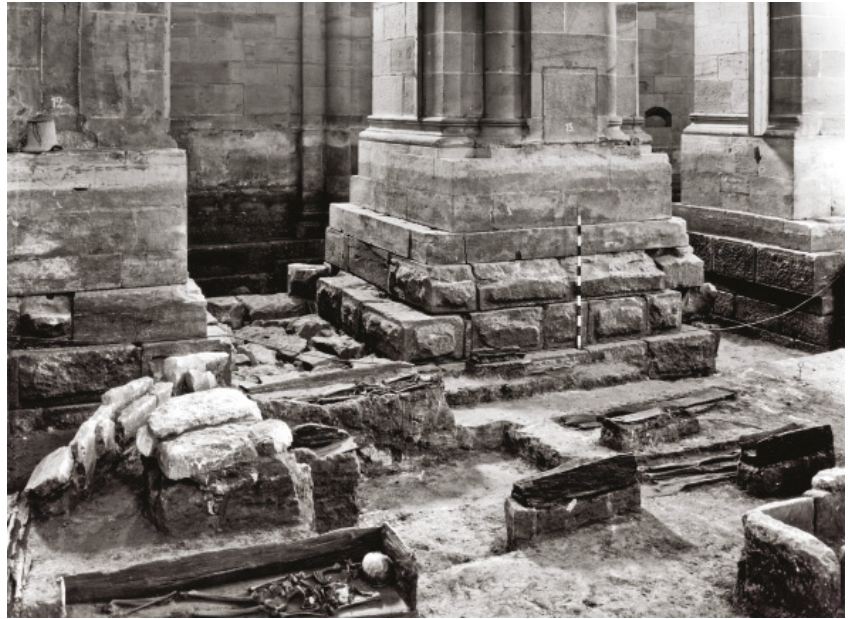
Abb. 12. Otterberg, Zisterzienserkirche, zweitverwendete Buckelquader im Fundament eines Mittelschiffpfeilers (GDKE, Direktion Landesdenkmalpflege Mainz, Bildarchiv).
