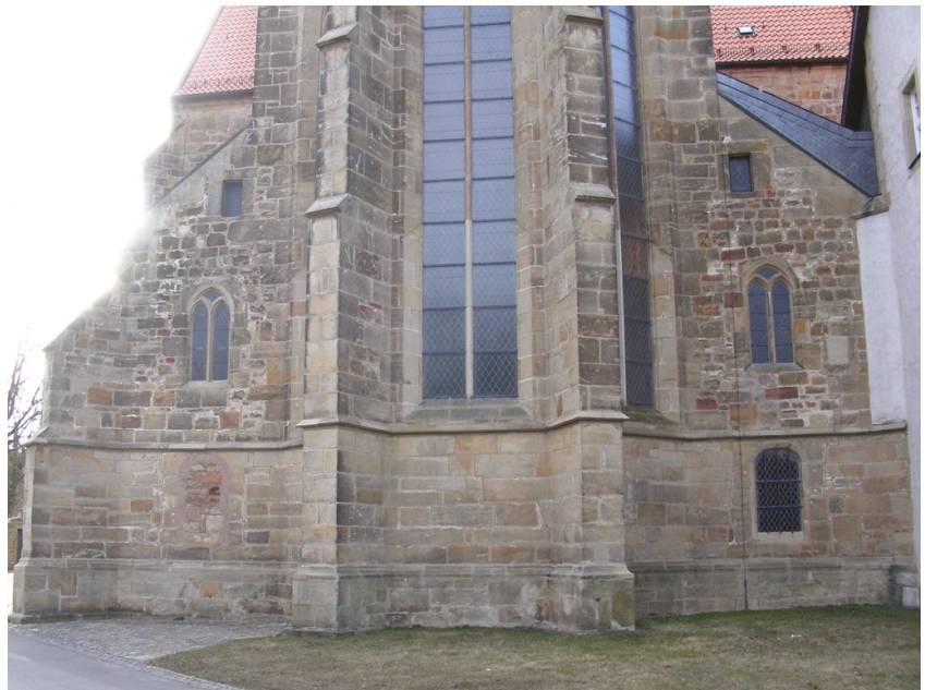
Abb. 2. Marienrode, Zisterzienserkirche, Altarhaus von Osten, mit gequaderter Sockelzone und später aus Bruchstein gesetzten oberen Wandabschnitten (Foto: Charlotte Lagemann, Heidelberg).
