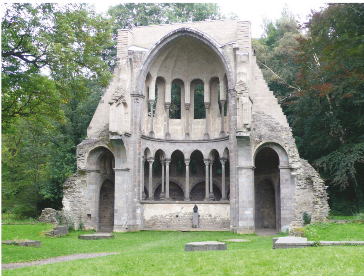
Abb. 5. Die Chorrueine ist der einzige obertägig erhaltene Rest des romanischen Klosterbaus (Foto: Christoph Keller).
