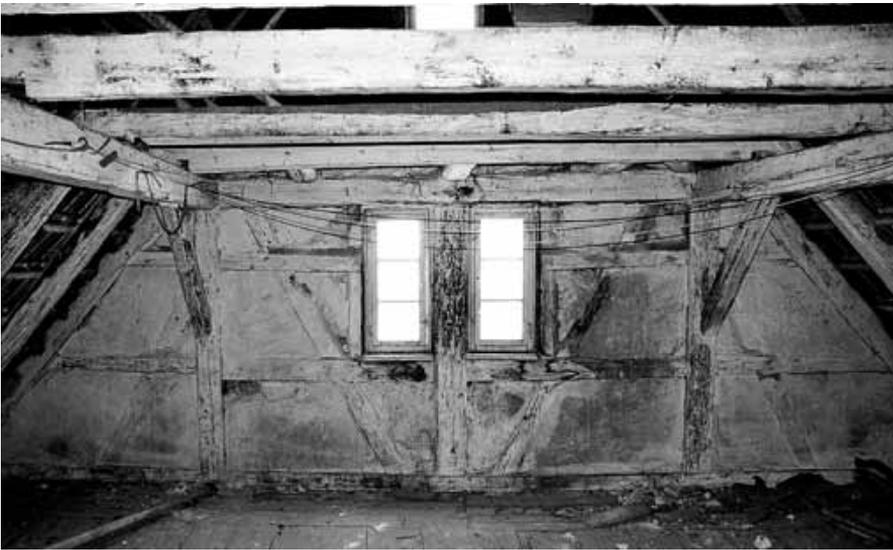
*Abb. 15* Reutlingen, Katharinenstraße 8 von 1726 d: Straßenseitiges Giebel Fachwerk (Südseite, 2. Dachgeschoss). Die Ausprägung des Fachwerks entspricht demjenigen von Rückgiebelfassaden.
