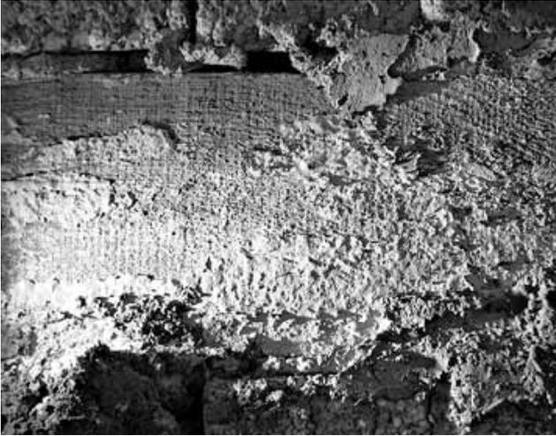
*Abb. 14* Reutlingen, Katharinenstraße 6 von 1726/27 d: Auf der Mühle aufgesägtes Bauholz aus Eiche am Nordgiebel (2. Dachgeschoss). Deutlich sind im Streiflicht die senkrecht zur Längskante verlaufenden Sägerillen erkennbar, die den regelmäßigen Vortrieb des Sägeschlittens anzeigen.
