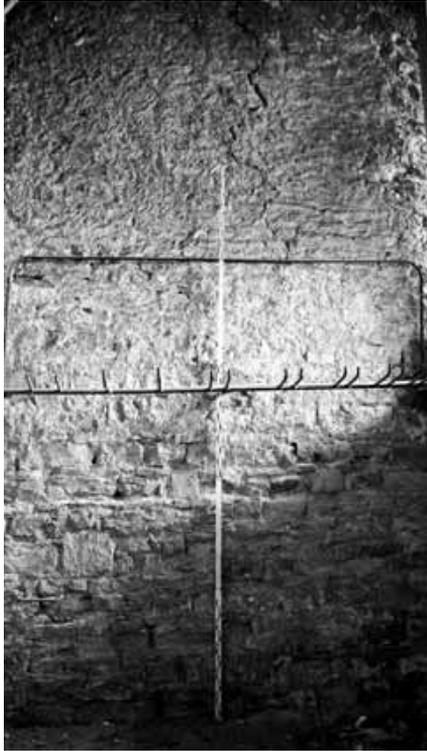
Abb. 4 Ostseite der Mauer in der Jos-Weiß-Str. 4, deutlich ist der Wechsel im Steinformat des Mauerwerks zu sehen.
