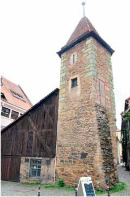
Abb. 10 Kesselturm, Nord- und Nord-Westansicht mit eingezeichnetem auffälligen Mauerwerkwechsel (grün) und Türsetzung zum Wehrgang (rot).
