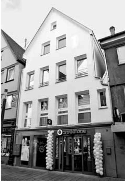
Abb. 17 Reutlingen, Wilhelmstraße 74/76: Modern umgestaltetes Gebäude von 1726/27 d. Abgesehen von ihrer ursprünglichen Fachwerksichtigkeit entspricht der schlichte Charakter des dreigeschossigen Doppelhauses ohne Vorkragungen dem Ursprungszustand von 1727.
