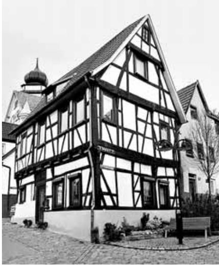
Abb. 29 Herrenberg, Am Burgrain 7 und 9: In beiden Fällen handelt es sich um kleine, mittelalterliche Wohnhäuser, die offenbar andernorts abgebrochen und nach 1635 nach Herrenberg versetzt wurden. Während am Sturz der Haustüre von Nr. 7 die Jahreszahl 1652 erkennbar ist, weist bei Nr. 9 nur das dendrochronologisch ermittelte Baudatum 1471 auf diese baugeschichtliche Besonderheit hin.
