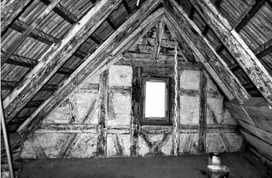
Abb. 9 Reutlingen, Marktplatz 2 (ehemaliges Zunftthaus der Metzger): Innenansicht des zur Markseite gewandten Giebelfachwerks in der oberen Dachebene von 1727 d.
