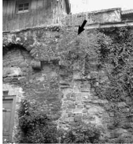
Abb. 14 Turmmauerabbruchstelle und Kragbogenwechsel, Jos-Weiß-Straße, rechts davon befindet sich der Durchgang zum Eisturm.
