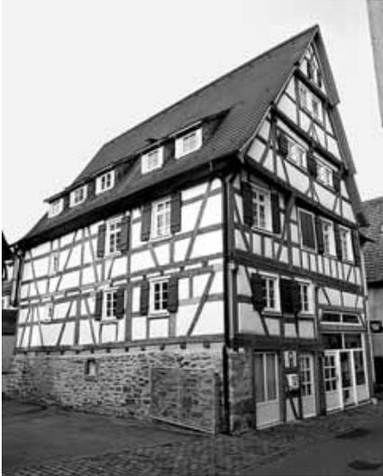
*Abb. 27* Herrenberg, Badgasse 21 von 1636 d mit wiederverwendeten, zusammenhängenden Bestandteilen von 1557 d. Das translozierte Dachwerk von 1557 passte offenkundig nicht mit der Parzelle des Hauses überein, weshalb man einen schräg verlaufenden Dachüberstand in Kauf nahm.
