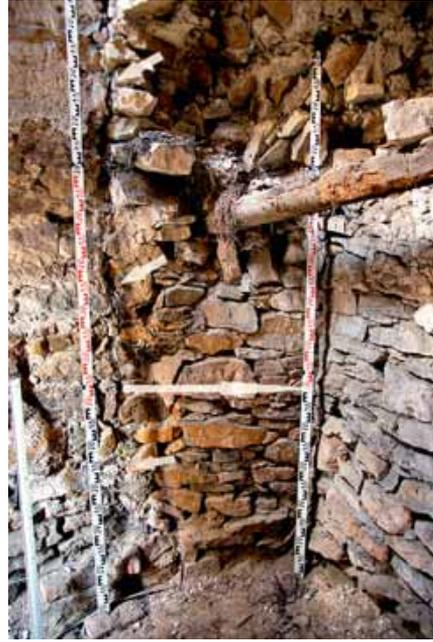
Abb. 11 Westliche Turmwange am Kesselturm mit durchgängiger Baufuge und tiefem, aber schön gesetztem Mauerausbruch.
